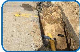
Las líneas de servicio de gas natural van desde la tubería principal fuera de su hogar y se conectan al medidor de gas que sirve a su hogar o negocio. Después de instalar una nueva tubería principal (Paso 3), también será necesario reemplazar las líneas de servicio, lo que requerirá una nueva excavación de la calle.
